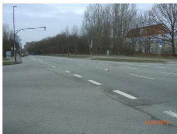
Neu asphaltierter Skandi-Damm
