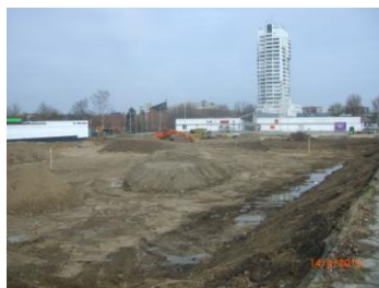
Baugelände Kaufland und Sozialzentrum
