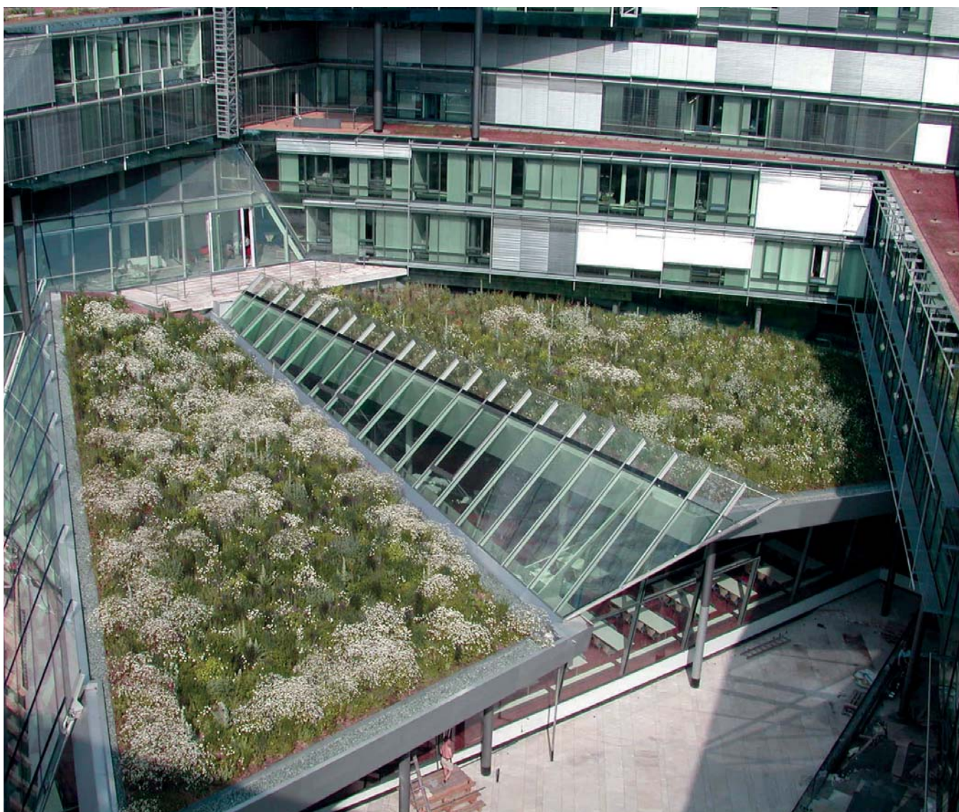
Abb. 18: Intensive Dachbegrünung auf dem Dach der Cafeteria eines Verwaltungsgebäudes. Die Dachbegrünung nimmt das anfallende Regenwasser auf, verdunstet es nach und nach und sorgt somit für ein ausgeglichenes Mikroklima im Innenhof.
