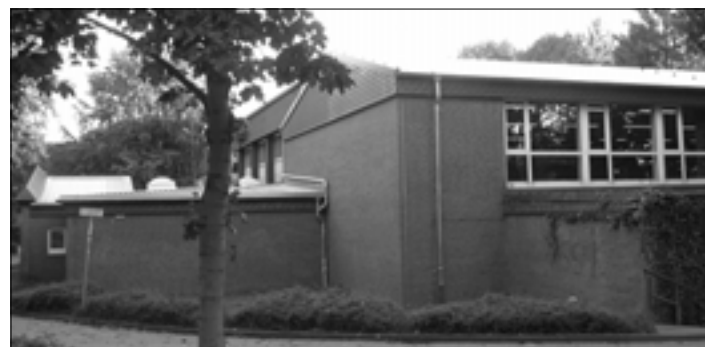
Die sanierten Hasloher Turnhallendächer
