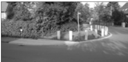
Ermöglicht einen sichereren Schulweg: die neue Einmündung Achtern Felln/Dorfstraße
