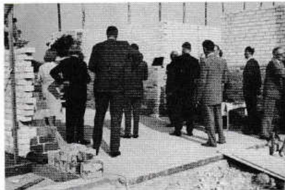
Gemeinsamer Besichtigungsrundgang auf der Baustelle nach der Grundsteinlegung
