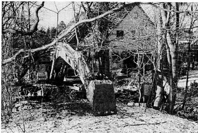
Lange hat es gedauert, bis die Tiefbauarbeiten zur Verlegung einer neuen Regenwasserleitung vom Fasanenweg entlang des Eisenbahndamms zum Regenwasserrückhaltebecken bei Charlottenhof in Angriff genommen wurden. Zuerst war der Boden zu nass, dann war er gefroren und danach wieder zu nass. Aber jetzt gehen die Arbeiten zügig voran, und die Anwohner des Fasanenwegs können hoffen, dass die Zeit der feuchten Keller endlich zu Ende geht.
