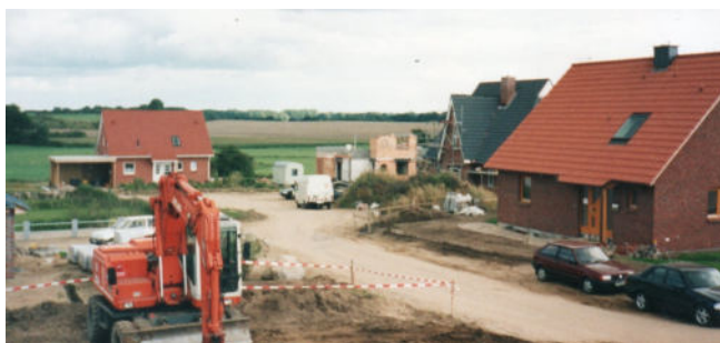
Für das Neubaugebiet Imbrook wird am 2. Mai 1997 der erste Spatenstich gemacht.
