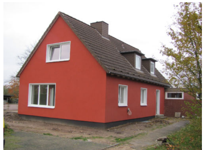
Im vergangenen Jahr 2012 wurde das ehemalige Lehrerwohnhaus energetisch saniert.
