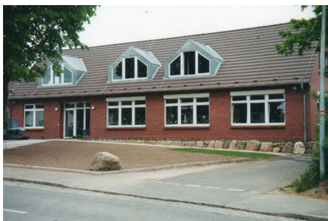
Am 22.03.1999 erfolgte der Baubeginn für die Erweiterung der Schule, Einweihung war am 07.09. desselben Jahres
