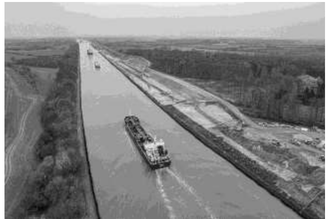
Quelle: WNA NOK Ausbau Oststrecke des Kanals
