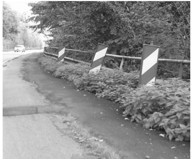
Somit sind vorerst die schlimmsten Schäden beseitigt, aber es kann auch eine trügerische Sicherheit sein. Also Vorsicht, denn durch das Abrutschen der Böschung kann es durchaus wieder weitere Risse in dem Belag geben. Und diese sind bedingt durch die Längsausrichtung extrem gefährlich und zudem in der dunklen Jahreszeit schlecht wahrzunehmen.
